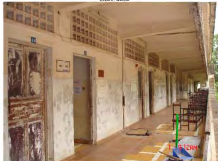
រូបភាពអាគារពីផ្នែកខាងក្រៅមុនពេលធ្វើការជួសជុល Outside view of the building before Renovation
