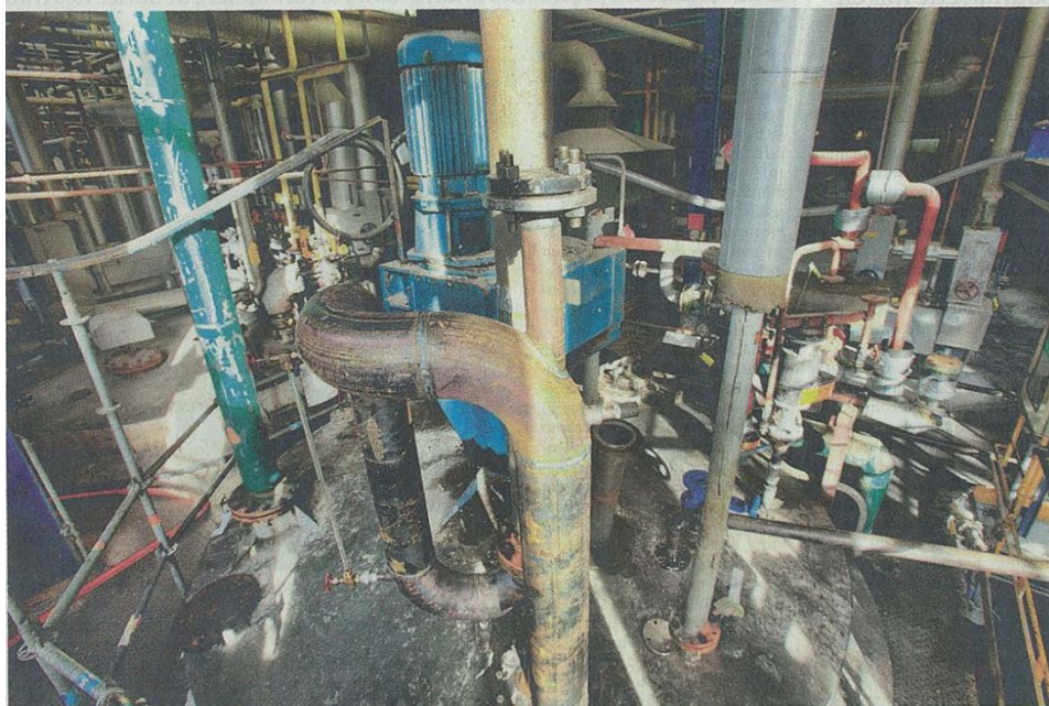
Dans l'usine Lubrizol de Rouen, la cuve de mercaptan d'où est partie la fuite le lundi 21 janvier. FRÉDÉRIC GRIMALD/« DIVERGENCE POUR LE MONDE »
